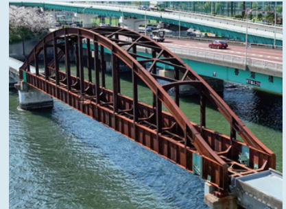
施工前の旧晴海鉄道橋。全体が赤茶色の錆で覆われている
