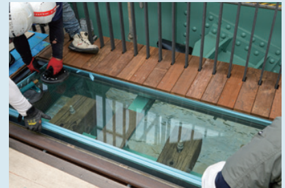
④復元した線路や海面をのぞき込むことができるガラス床を設置
