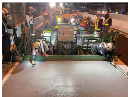
首都高速道路でのLSF試験施工実施状況
