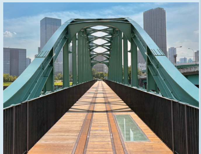
④復元した線路や海面をのぞき込むことができるガラス床を設置
