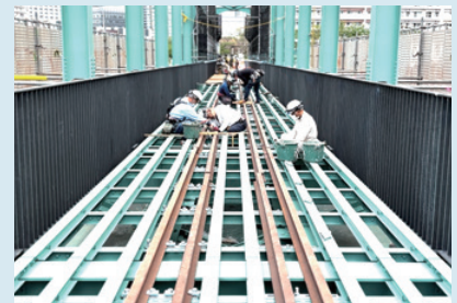
②床の土台を設置した後、供用当時のレールを復元
