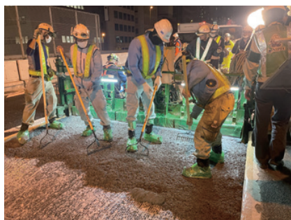
首都高速道路でのLSF試験施工実施状況
