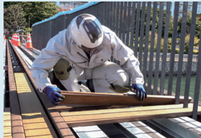
③レールを包み込むようにウッドデッキを設置
