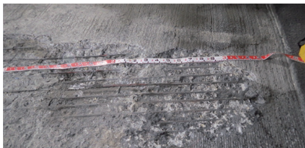
舗装補修工事において、舗装を剥がすとその下の床板にも大きく損傷が見られ、鉄筋も腐食している状況であった
