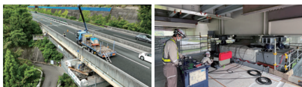
(左) 供用中の橋梁での施工の様子。工事用クレーンのすぐ横を一般車両が通行している (右) 上部工のジャッキアップの様子。支承を交換するため、供用中の橋桁をジャッキで持ち上げている
