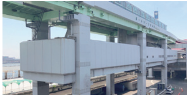
鉄道分野の工事例（神戸新交通ポートアイランド線耐震補強工事（PT駅及びJNK駅）施工完了後）
