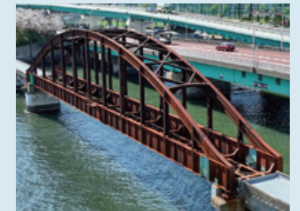
施工前の旧晴海鉄道橋。全体が赤茶色の錆で覆われている
