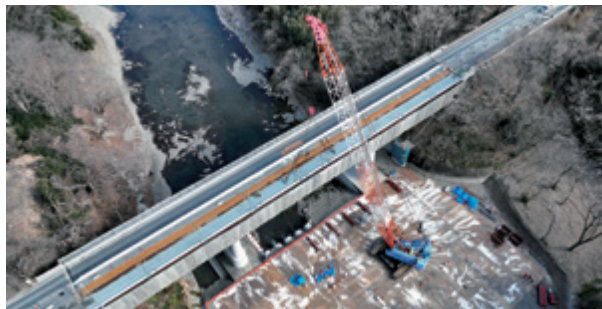
上部工拡幅工事の様子
