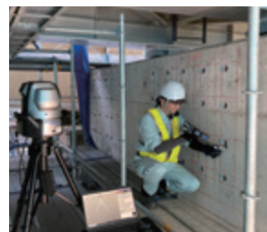
3D計測機を用いたアンカーボルト削孔位置の計測状況
