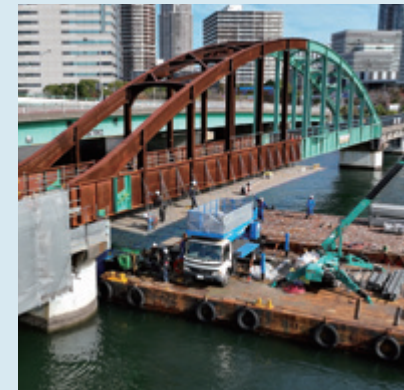
①供用当時に再現した色で塗替塗装
