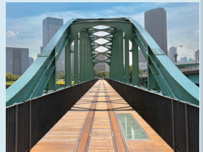
④復元した線路や海面をのぞき込むことができるガラス床を設置
