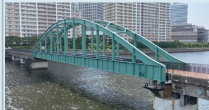
③レールを包み込むようにウッドデッキを設置
