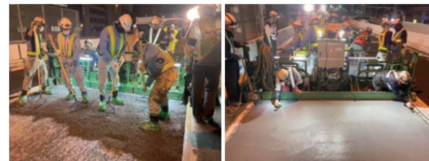
首都高速道路でのLSF試験施工実施状況
