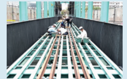
②床の土台を設置した後、供用当時のレールを復元
