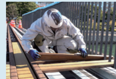
③レールを包み込むようにウッドデッキを設置
