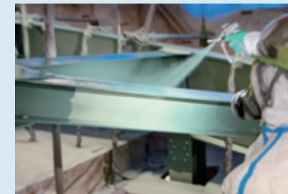
①供用当時に再現した色で塗替塗装
