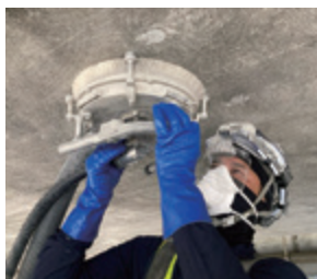
WJを用いたコンクリートの表面処理
