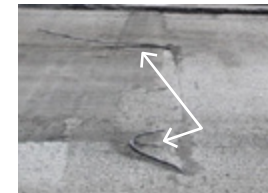
鉄筋の露出事例※
