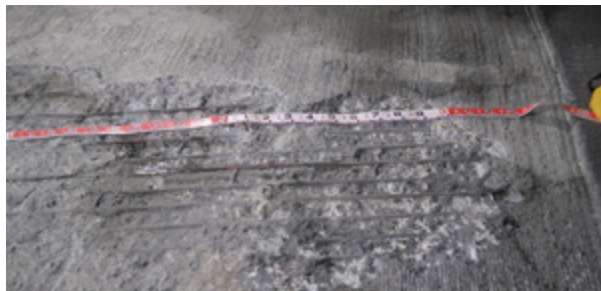
舗装補修工事において、舗装を剥がすとその下の床板にも大きく損傷が見られ、鉄筋も腐食している状況であった
