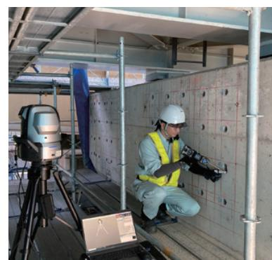
3D計測機を用いたアンカーポルト削孔位置の計測状況
