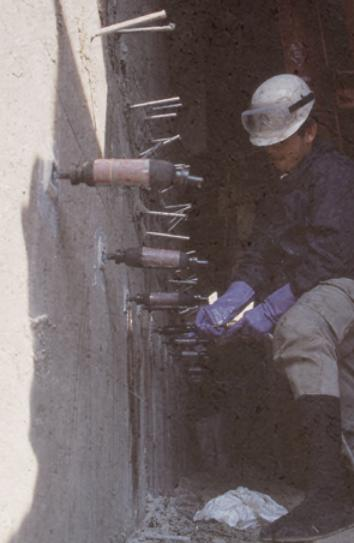
樹脂注入による橋脚のひび割れ補修
