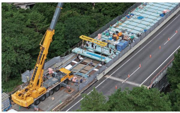
天狗橋での床版取替施工
