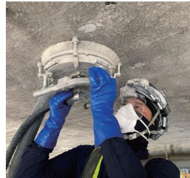
WJを用いたコンクリートの表面処理
