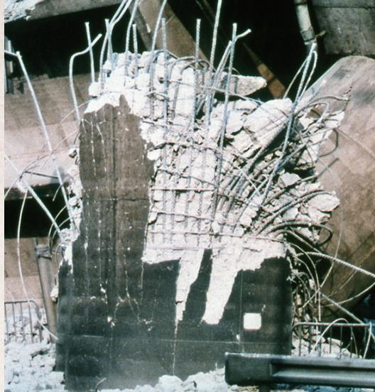
崩壊した高速道路橋の橋脚
