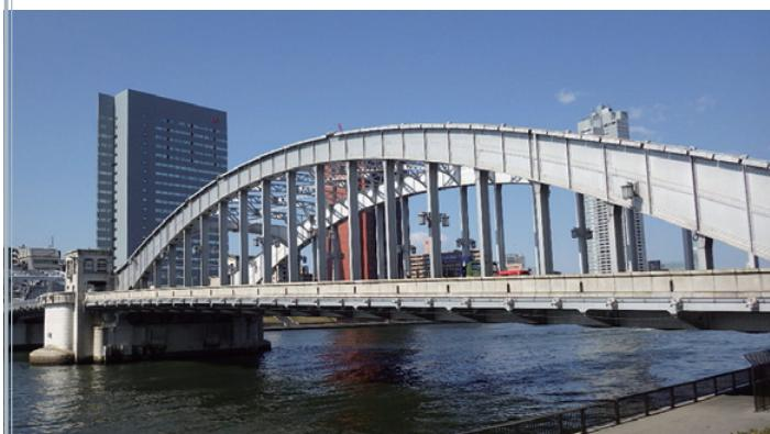
勝闘橋は、隅田川の河口近くに架かる跳開橋です。大型船の通行のため中央部分が開閉できる構造になっており、国内最大の可動支間を有しています。この橋は、昭和15年（1940年）に開催予定だった万国博覧会会場へのメインゲートとしても位置付けられ、わが国の技術力を示すべく、当時の先端技術を結集して架けられました。わが国の橋梁技術史に残る貴重な建造物として国の重要文化財に指定されているとともに、産業近代化の過程を物語る存在として経済産業大臣より近代化産業遺産に認定されています。
