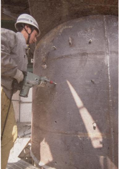
鋼板巻立工法による橋脚補強
