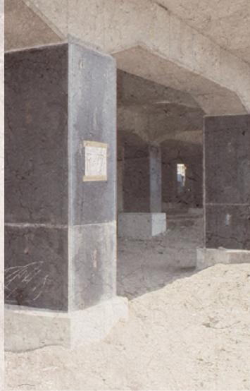
鋼板接着により補強された新幹線高架橋の橋脚
