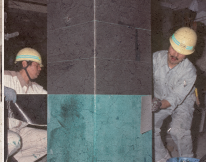
CFRPを用いた柱の補強
