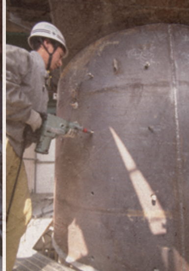
鋼板巻立工法による橋脚補強
