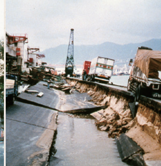
埋立地の護岸付近で生じた大きな陥没
