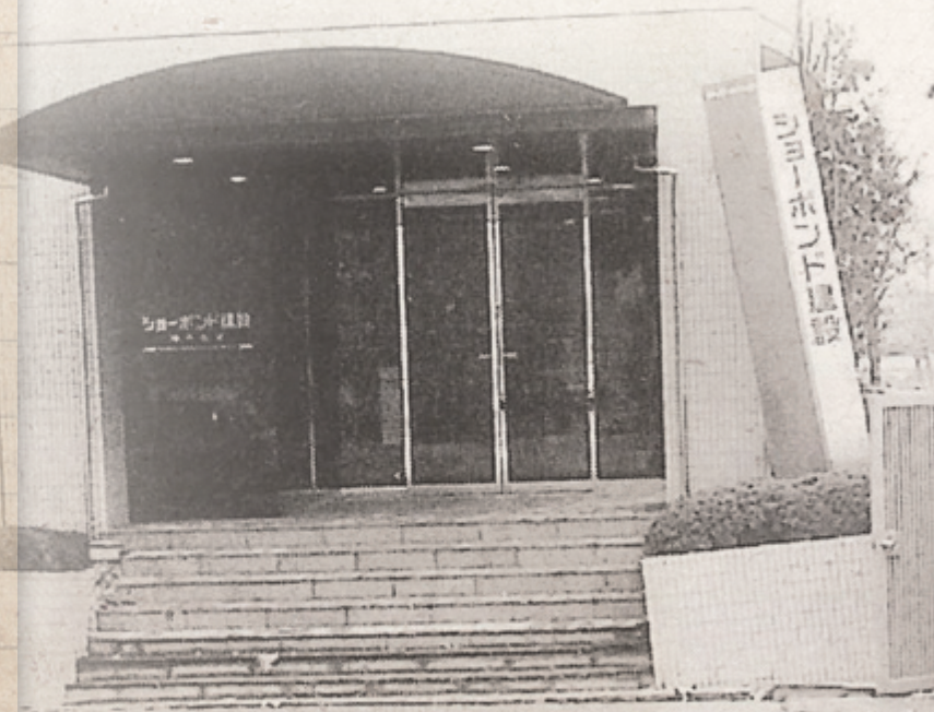
傾いた神戸支店ビル
