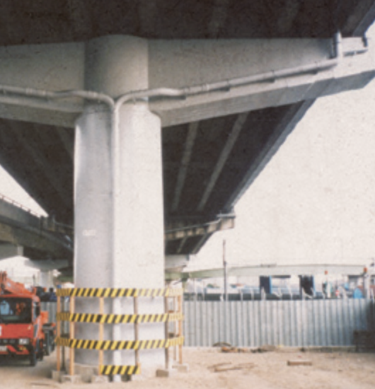
震災直前に完成した橋脚補強箇所には被害はなかった
