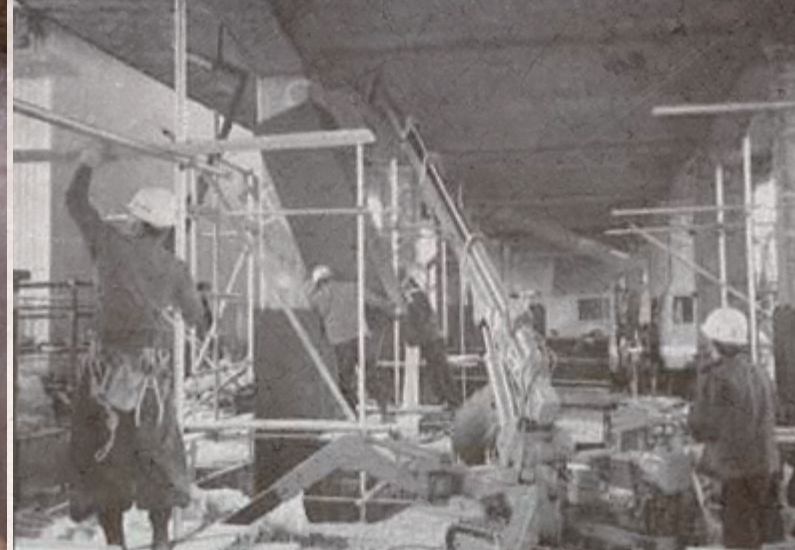
新幹線復旧工事の現場
