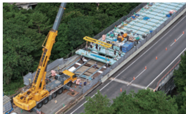
天狗橋での床版取替施工
