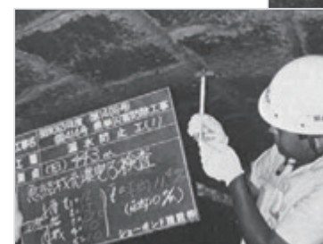
施工中の様子（当時の社内報より）
