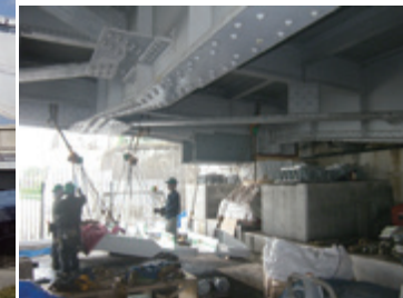
施工中の様子
