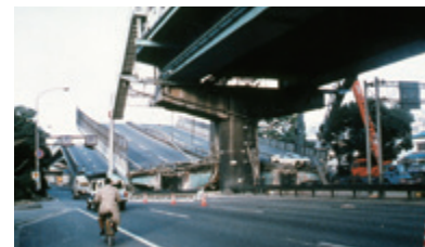
1995年 落橋した阪神高速道路の高架橋
