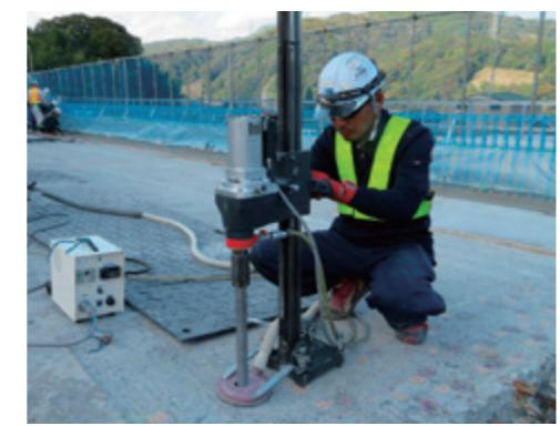
高周波コアドリルによるアンカーボルト削孔の様子
