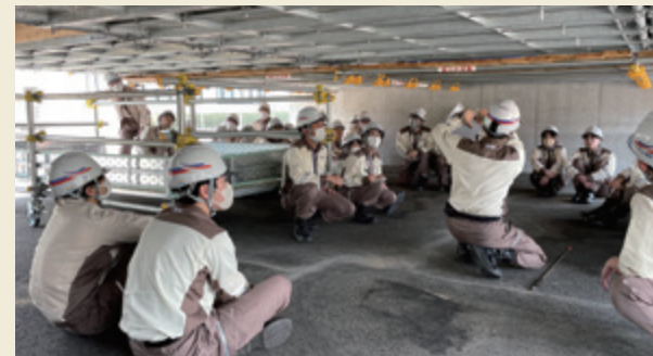
研修用橋梁での足場講習
