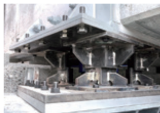
実際に設置された移動制限装置
