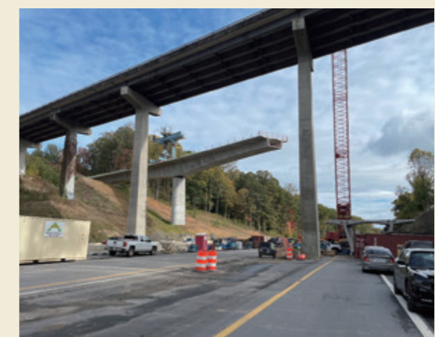
ST社の施工現場
