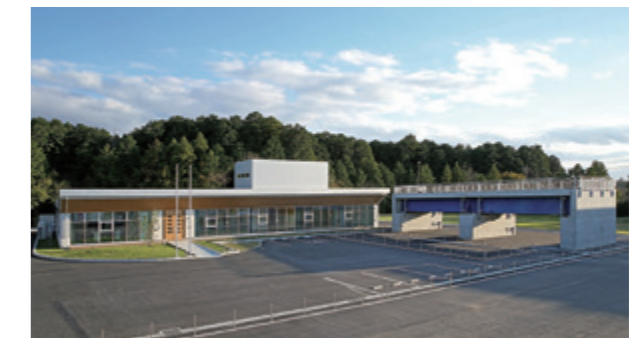
つくば研修センター全景
