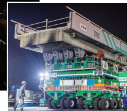
撤去橋梁運搬状況
