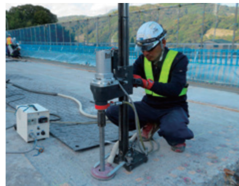
高周波コアドリルによるアンカー削孔の様子
