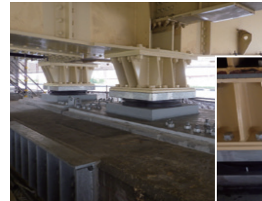
支承取替完了
