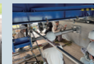
耐震補強装置の施工実習
