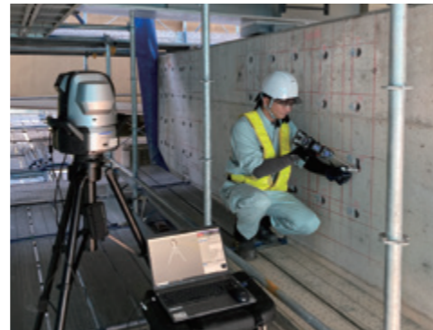
3D計測機を用いたアンカーボルト削孔位置の計測状況
