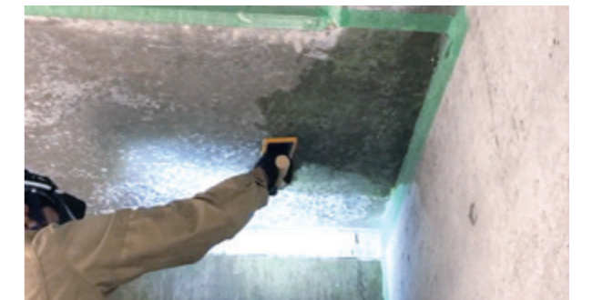
SBLNジェルの施工状況
