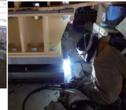
支承取替施工状況
