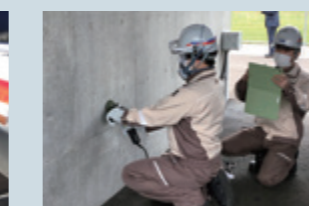
施工写真撮影実習（サンダーでの下地処理）
