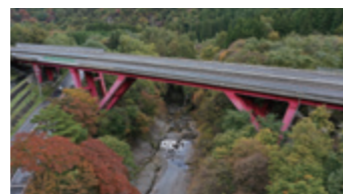
東北自動車道 天狗橋
