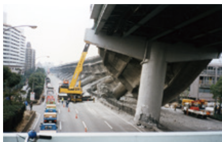
1995年 震災で倒壊した阪神高速道路
