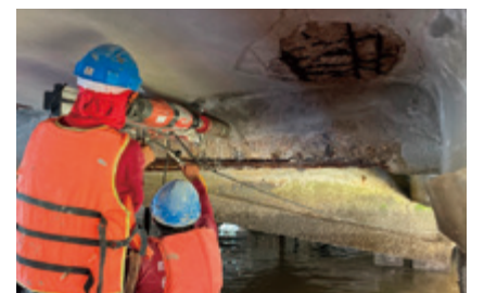
タイでの港湾補修現場
