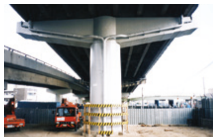
1995年 震災直前に完成した橋脚補強箇所 被害はなかった
