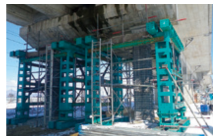
2011年 東日本大震災で被災した東北新幹線 橋脚の工事
