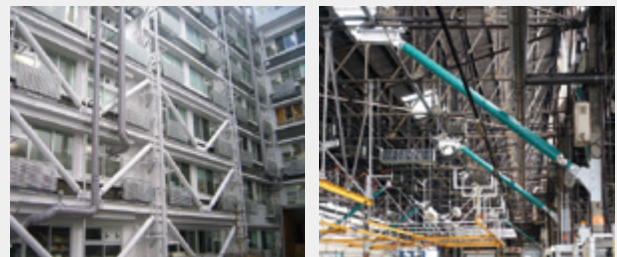
補強工事の様子
