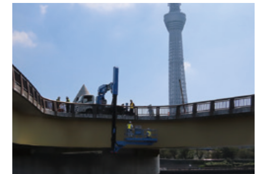
現地調査の様子
