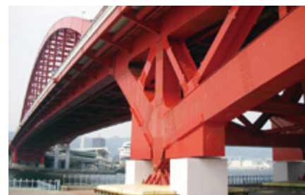
2011年 土木学会関西支部技術賞を受賞した 神戸大橋の工事
