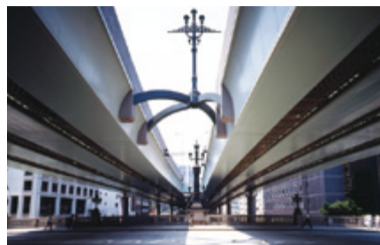
1991年 日本橋高架橋外装工事
