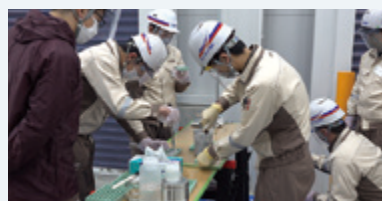
有機材料の施工実習
