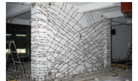
1981年 建設省建築研究所の日米共同大型耐震実験で ピックス工法が採用に
