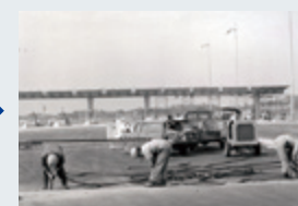
1967年 東名高速道路名古屋 インターでのカットオフ ジョイント新設工事
